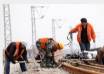
黄韩侯铁路侯西段电气化复线施工进度顺利
